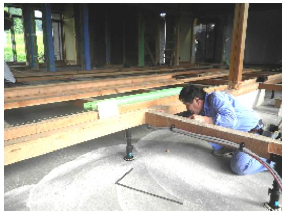
F様邸は住居部分を中心とした全面リフォームをさせて頂いています。床下に湿気・白アリ対策のために、全面防湿コンクリートを施工させて頂きました。
