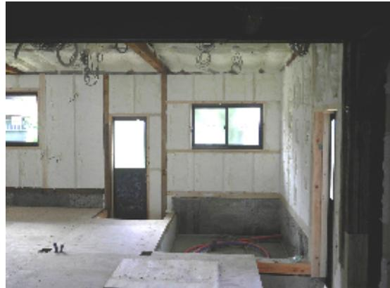
O様邸は水廻りを中心にリフォームさせて頂いています。こちらのお宅では、一部家を浮かした状態で基礎をして、家を耐震補強をしました。また、冬に暖かい暮らしをしていただくために、高気密高断熱の吹付け断熱アイシネンを施工させて頂きました。
