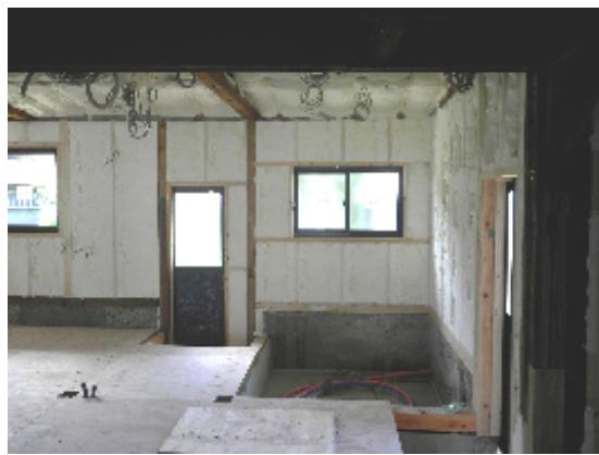
O様邸は水廻りを中心にリフォームをさせてもらっています。こちらのお宅では、一部家を浮かした状態で基礎をして、家を耐震補強をしました。また、冬に暖かい暮らしをしていただくために、高気密高断熱の吹付け断熱アイシネンを施工させてもらいました。
