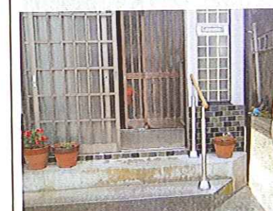
玄関外手すり設置
