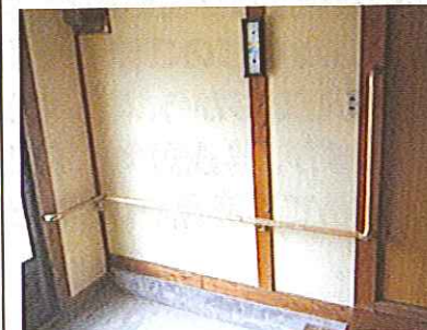
玄関手すり設置
