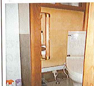
柱の角に手すり
