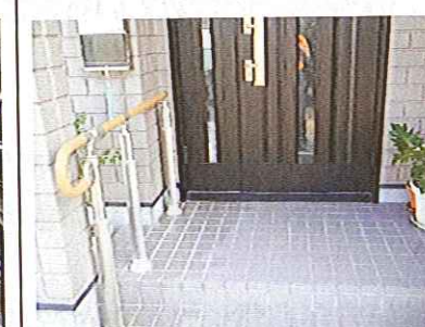
玄関外手すり設置
