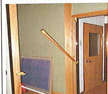
遮断式手すり設置
