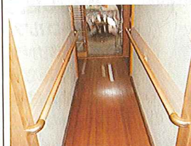
廊下手すり設置
