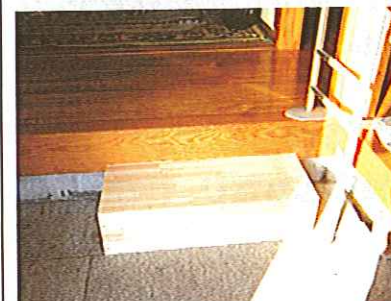
玄関踏み段・手すり設置
