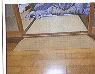
居間段差解消スロープ
